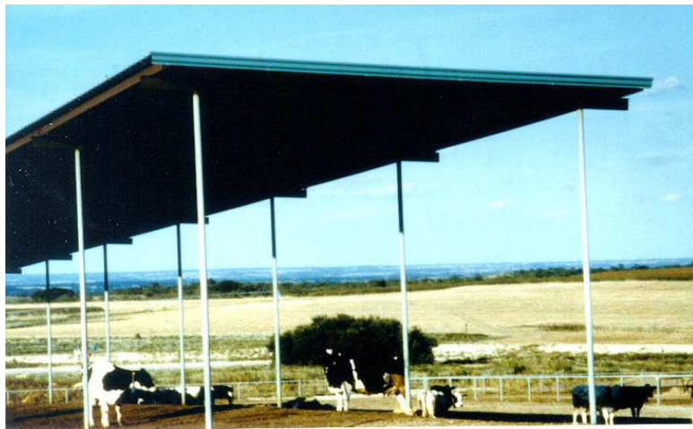
Obr. 40 Důležitým předpokladem, jak zabránit tepelnému stresu, je zajištění stínu
