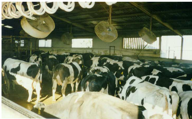
Obr. 36 Umístění ventilátorů v čekárně před dojárnou v kombinaci s postřikovačem, je velmi vhodné a ekonomické.
