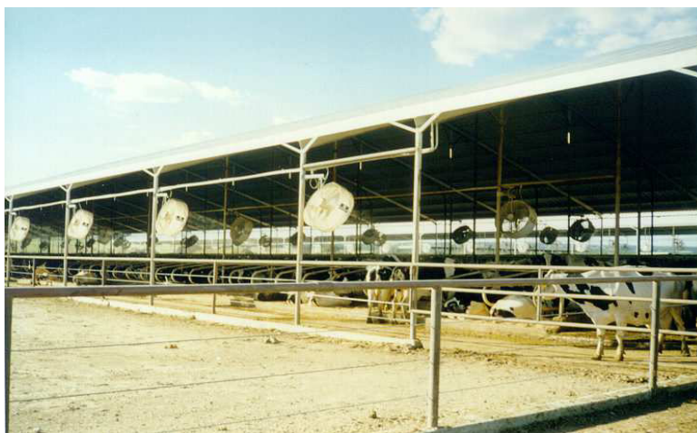
Obr. 32 Teplota vzduchu může být snižována ochlazováním pomocí větrání, ale mnohem efektivnější je ochlazování odpařováním vody (evaporační)
