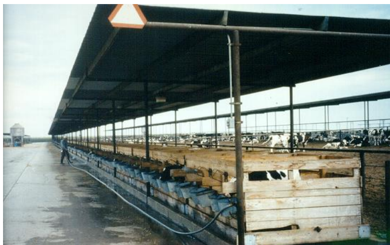
Obr. 18 Zastínění vnějších individuálních kotečů přístřeškem
