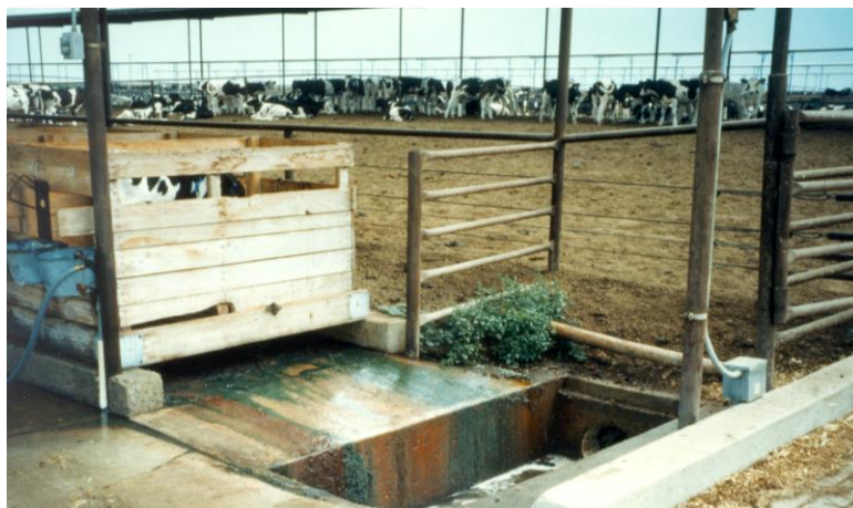
Obr. 19 V letním období se doporučuje splachování exkrementů vodou, vzduch se částečně ochlazuje
