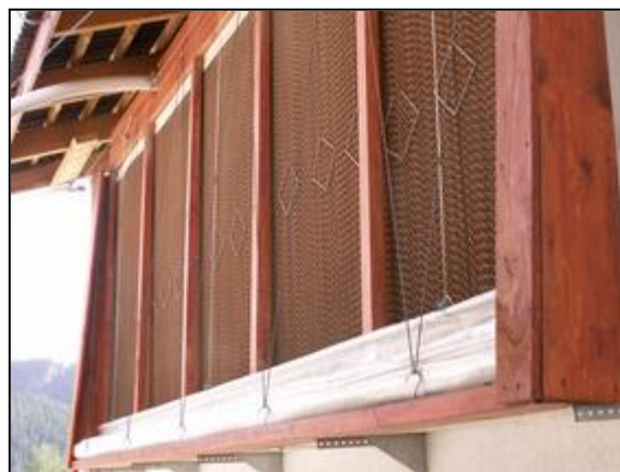
Obr. 11 Pohled na instalovaný deskový chladič
