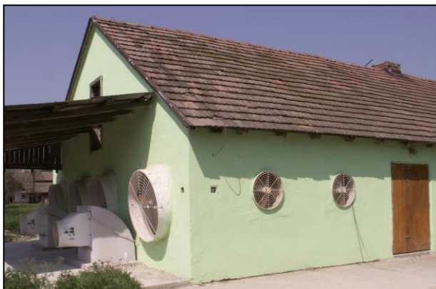
Obr. 6 Osazení ventilátorů v objektu pro výkrm prasat
