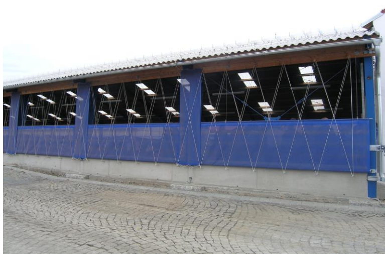
Obr. 22 Otevřená stáj by měla být proti průvanu chráněna speciální sítí
