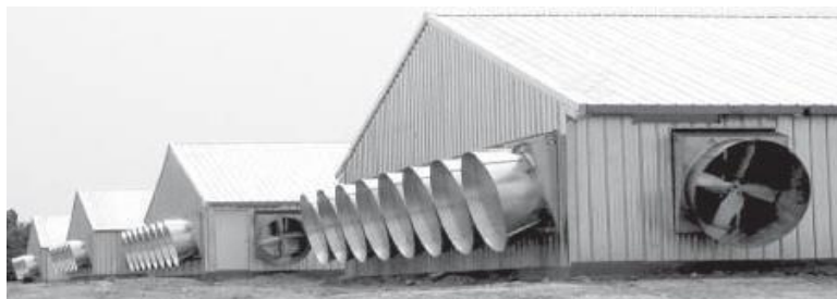
Obr. 39 Tunelové větrání se doporučuje i v halách pro výkrm brojlerů
