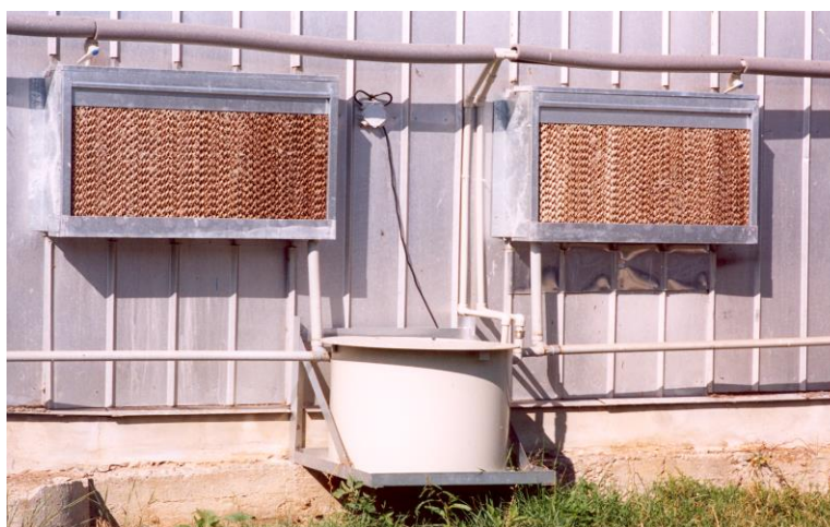
Obr. 41 Vzduch je nasáván těmito chladícími vložkami a na protilehlé straně je odsáván ventilátory ven z objektu
