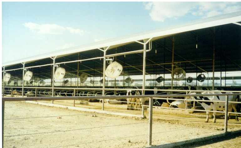
Obr. 28 Teplota vzduchu může být snižovaná ochlazováním pomocí větrání, ale mnohem praktičtější je ochlazování odpařováním vody (evaporační).
