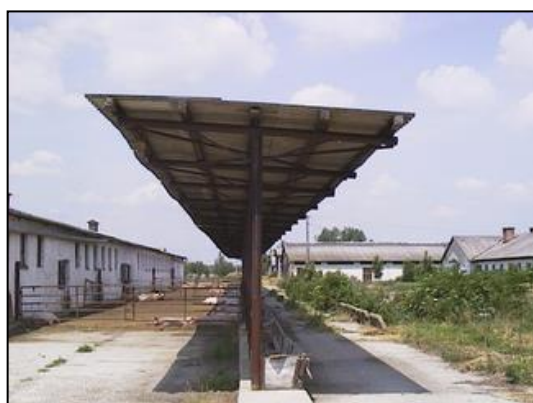
Obr. 12 Přístřešek s částečným stíněním výběhu pro ustájené prasnice
