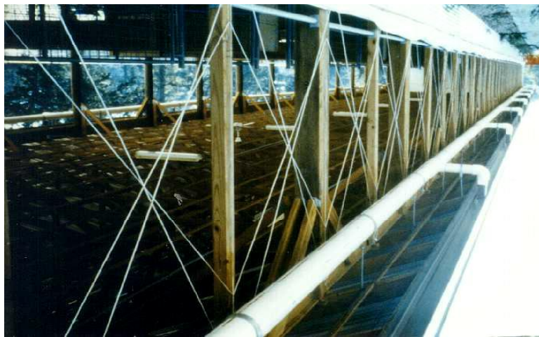
Obr. 27 Ve stáji by mělo dobře fungovat přirozené větrání. Velmi jednoduché a účinné jsou shrnovací závěsy nebo stahovatelné rolety
