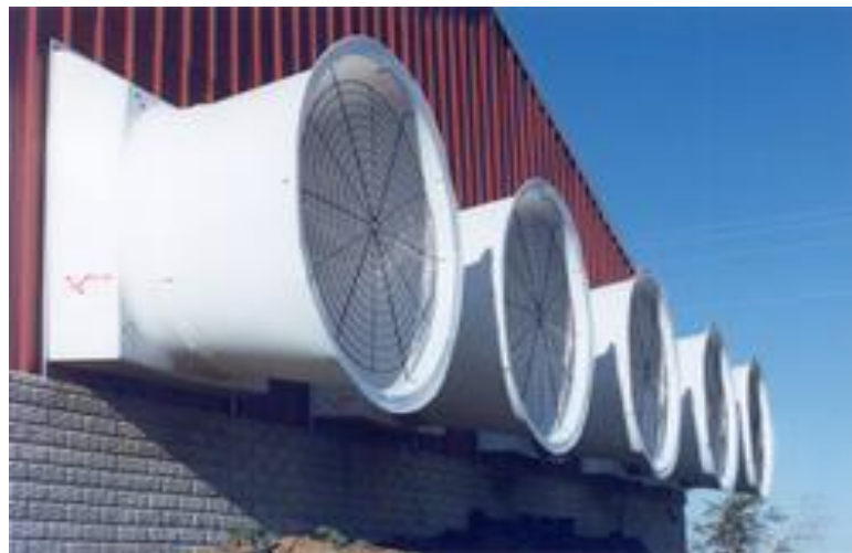
Obr. 38 Výkonné nasávací ventilátory
