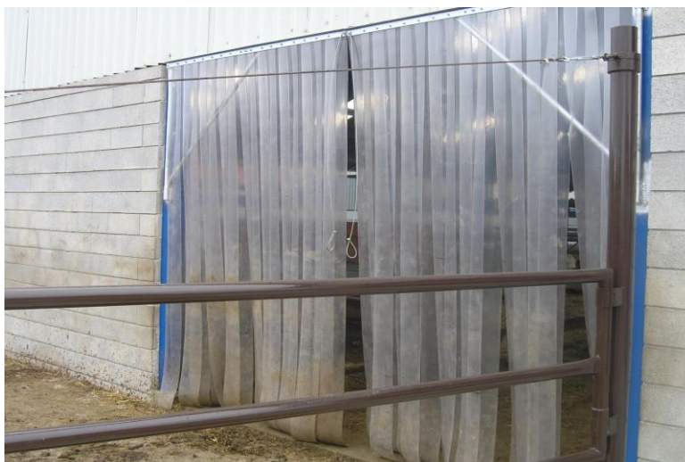
Obr. 21 Otvory jsou uzavřeny jen pásy z PVC
