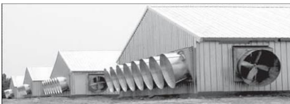
Tunelové větrání se doporučuje i v halách pro výkrm brojlerů (Brouček a kol., 2008)
