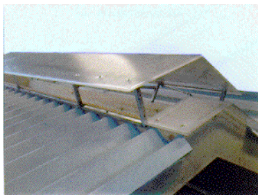
Prekrytá vetracia štrbina v hrebeni strechy
