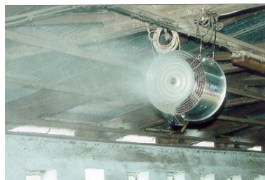
Ochladzovanie maštale vodnou hmlou
