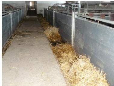
Obežný zhrňč s otvoreným kanálom v pôrodnici prasnice
