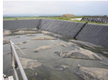
Lagúna na skladovanie hnojovice s dvojvrstvovou fóliou
