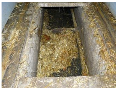
Kanál priamovratného zhrňča hnoja
