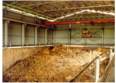
Zastrešené hnojisko s možnosťou vrstvenia hnoja do výšky 6 m pomocou mostového žeriavu
