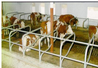
Roštová podlaha v pohybovej chodbe
