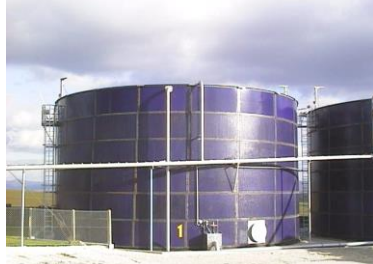
Nadzemná oceľová skladovacia nádrž na hnojovicu
