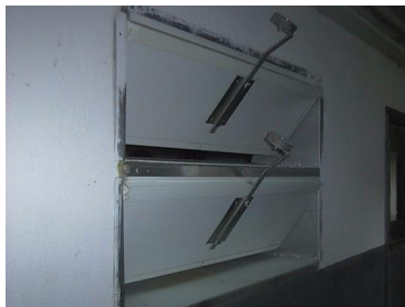
Samotiažne prívodné klapy
