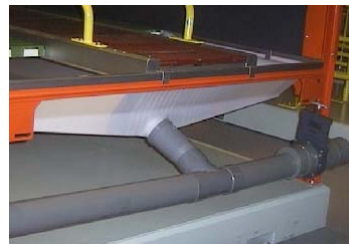
Kalová vaň s odtokovým potrubím a uzáverom
