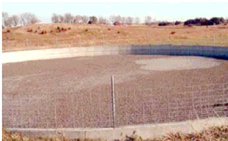
Prekrytie povrchu hnojovice v lagúny LECA materiálom
