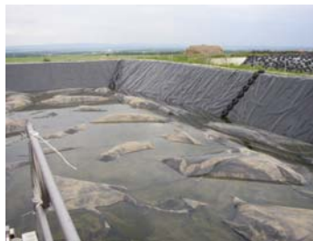
Lagúna na skladovanie hnojovice s dvojvrstvou fóliou
