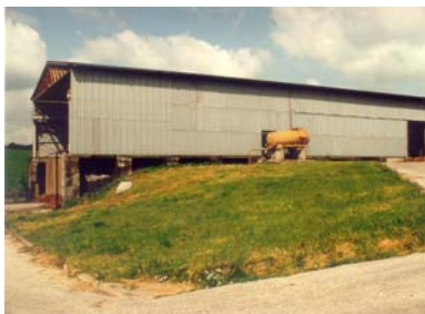
Zastrešené hnojisko s možnosťou vrstvenia hnoja do výšky 6 m pomocou mostového žeriavu
