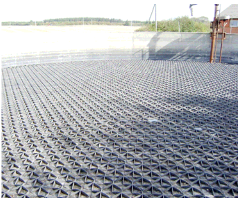
Detailný pohľad na tvarové riešenie HEXA dlaždíc a ich použitie v nádrži na prekrytú hladinu hnojovice
