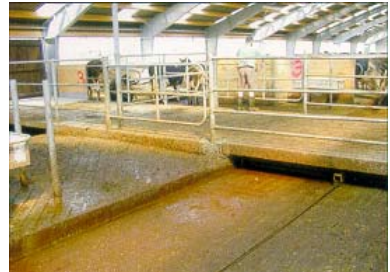
Osadenie zberného kanála v strede maštale
