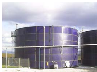
Nadzemná ocelová skladovacia nádrž na hnojovicu
