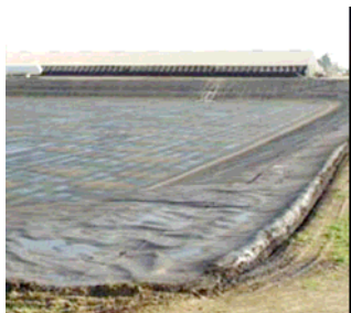
Prekrytie lagúny geotextílnou fóliou
