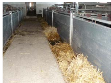
Obežný zhrňovač s otvoreným kanálom v pôrodnici prasníc
