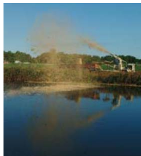
Pokryvanie lagúny rezanou slamou
