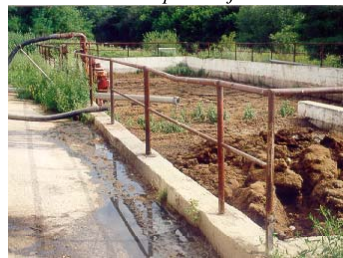
Plávajúca vrstva v podzemnej nádrži na hnojovicu od hovädzieho dobytku
